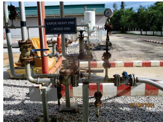
รูปที่ 45 อุปกรณ์ตรวจสอบการรั่วไหลที่แนวท่อขนส่ง
