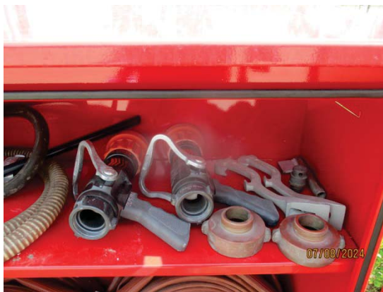
หัวฉีดน้ำดับเพลิง (Fire Water Nozzle / Monitor)
