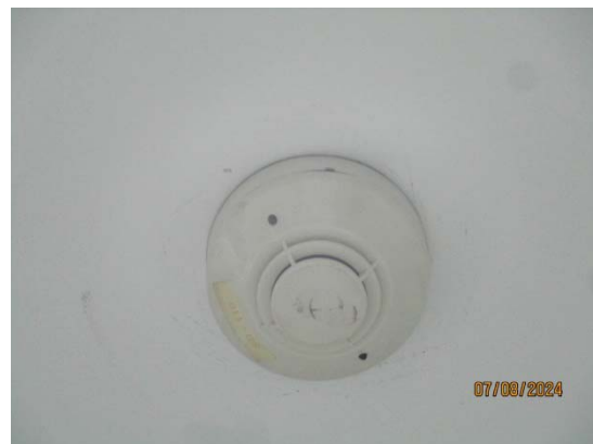
รูปที่ 30 Smoke Detector
