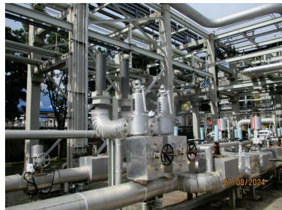
รูปที่ 51 วาล์วนิรภัยบริเวณแนวท่อขนส่ง
