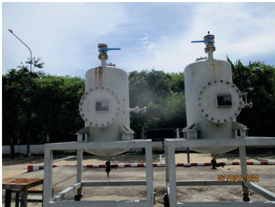
รูปที่ 5 หอดูดซับด้วยถ่านกัมมันต์ (Activated Carbon Adsorber)
