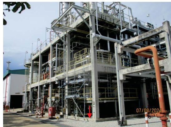
รูปที่ 54 คันกันบริเวณถังเก็บ สาร 1,3 บิวทาไดอิน
