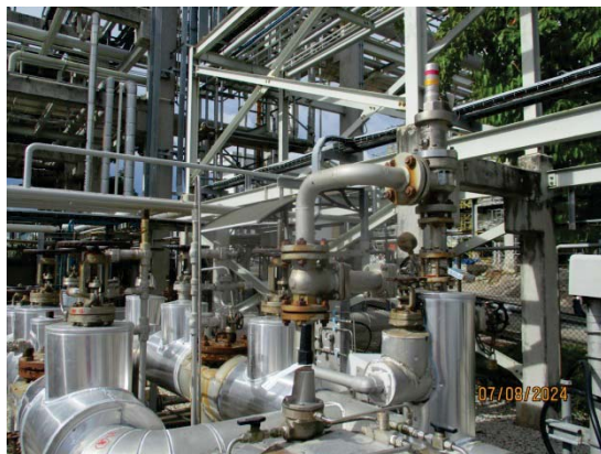
รูปที่ 51 วาล์วนิรภัยบริเวณแนวท่อขนส่ง
