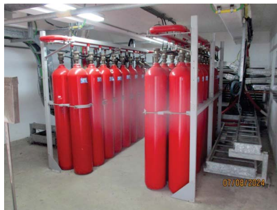
ระบบก๊าซคาร์บอนไดออกไซด์ (CO 2 )
